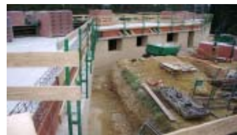
Photos du chantier : © Mahmoud Allaya
